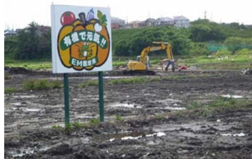
大量にあった瓦礫が無くなった状態
