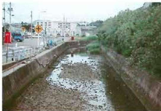
最近の宇田川では、干潮時でも両側を水が流れている。約500トンのヘドロが無くなったと推計される。
