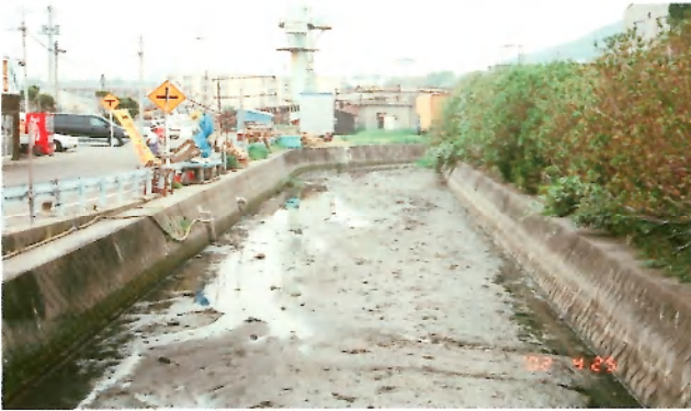
放流開始当時の干潮時の宇多田川 汚泥が堆積し、片側しか水が流れていない。
