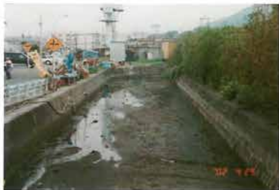
2002年の干潮時の宇田川の様子。ヘドロが堆積し、片側しか水が流れていなかった。
